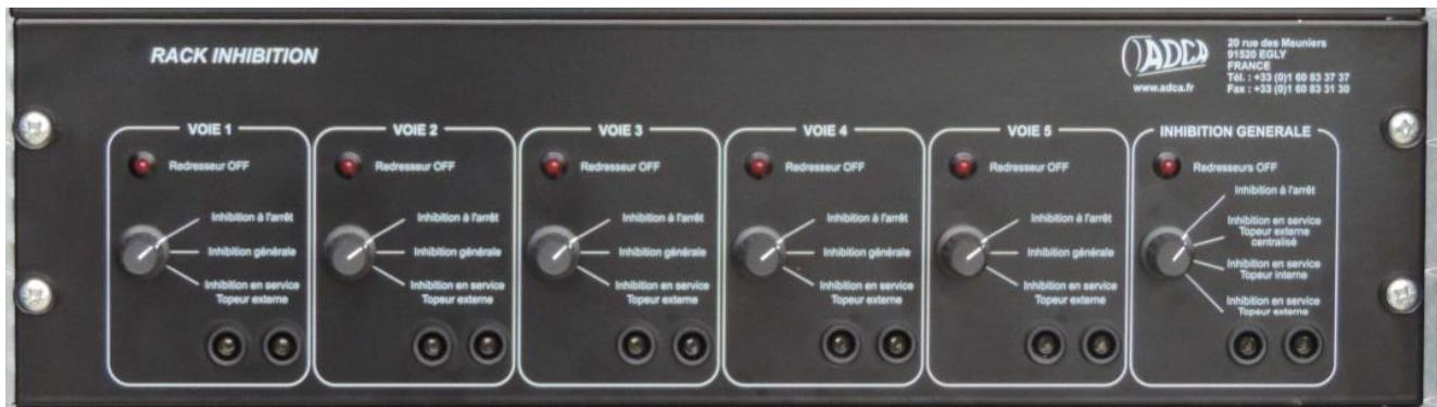
Le rack d'inhibition possède 5 voies pour 5 racks redresseurs et une voie générale.
